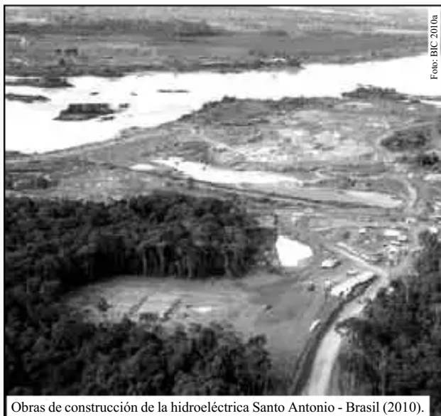
Obras de construcción de la hidroeléctrica Santo Antonio - Brasil (2010).
