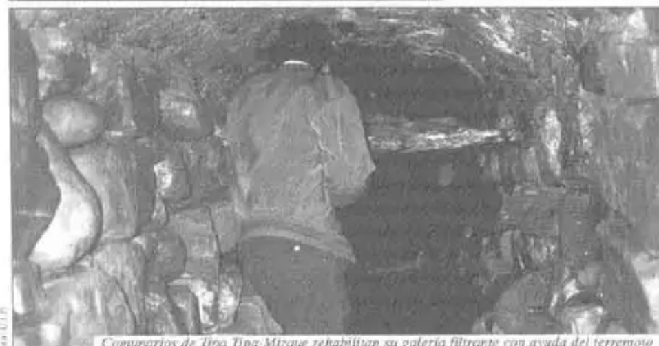
Comunarios de Tipu Tipu-Mizque rehabilitan su galería filtrante con ayuda del terremoto
